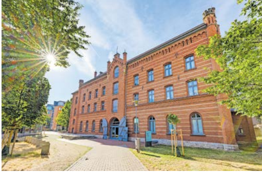
Der Benary-Speicher befindet sich in der Brühler Straße 37.
