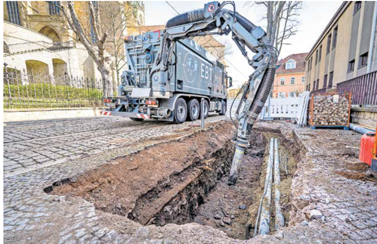
Ein Saugbagger – hier im Jahr 2025 in der Domstraße – ermöglicht es, Baumgruben behutsam von Erde zu befreien.
