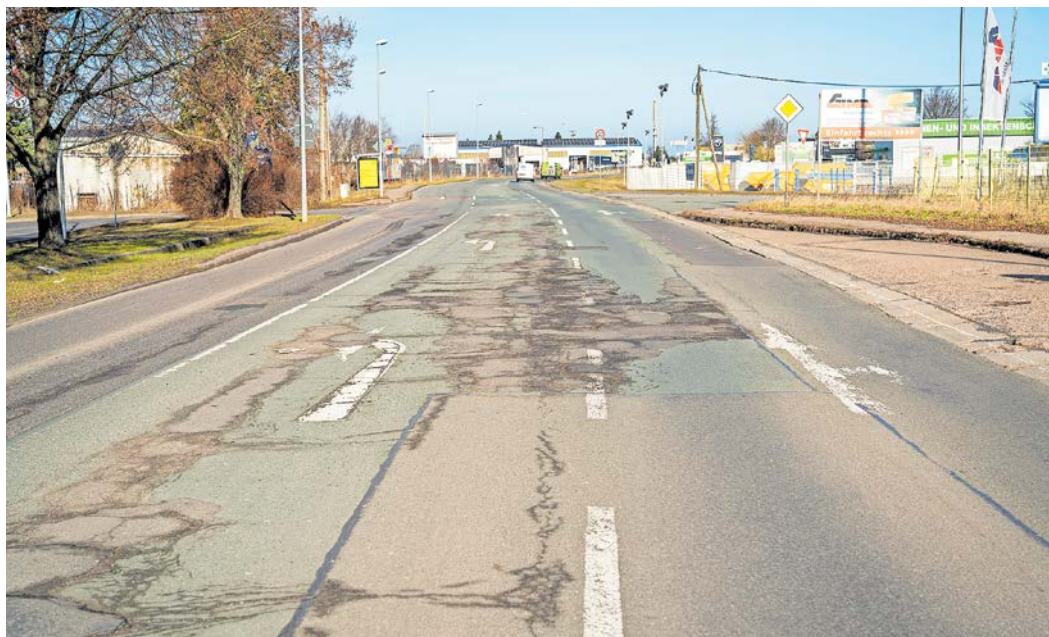
Die August-Röbling-Straße befindet sich in einem sehr schlechten Zustand. Ab Mitte des Jahres soll sie ausgebaut werden.
