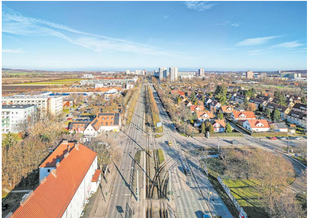
Die Sanierung der Nordhäuser Straße wird fortgesetzt. Der nächste Bauabschnitt beginnt südlich der Kreuzung Warschauer Straße/Augsburger Straße und endet vorm Knoten Marie-Elise-Kayser-Straße/Donaustraße (vorne im Bild).
